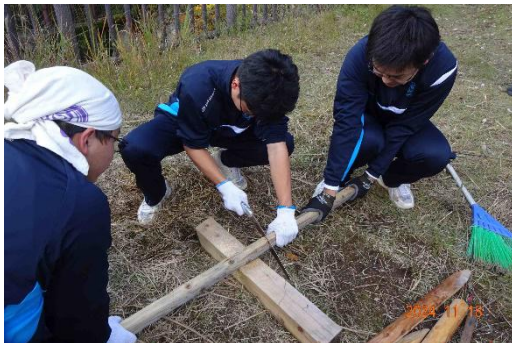
一本の丸太杭を横木用と杭用に切断
